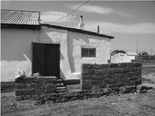
写真3 日干レンガ造りの定居家屋の増築。土台には石が使われている。日干レンガに泥を塗って漆喰で塗り固める。バヴロダル州バヤナウル地区、2014年。
