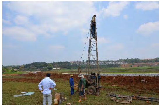
図5. ベトナム中央高原のブレイク火山帯の火口での掘削試料採集(2017年2月)
