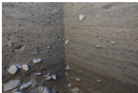
写真5 PT02北壁および東壁において観察された垂直付加堆積物。南西方向から撮影。
